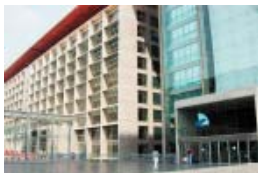
Centro de Justicia de Santiago, ubicado en Avenida Pedro Montt N° 1606.
